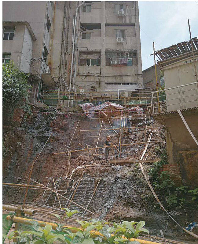
▲昨日,记者在现场看到,护坡加固施工正在进行中,预计7月底可以完工 记者 李卉摄
