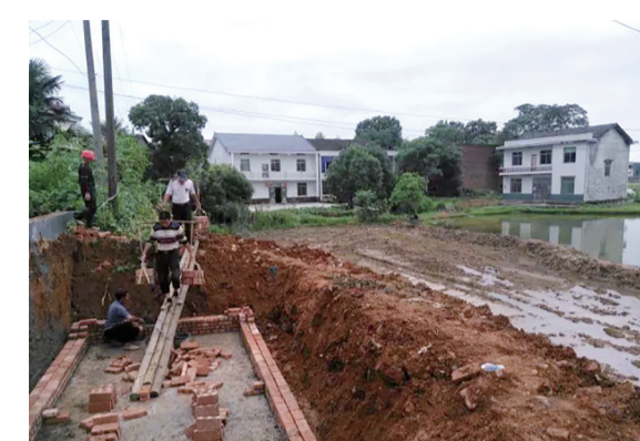
▲工人正在修筑“人工湿地”的沉淀池 通讯员供图
