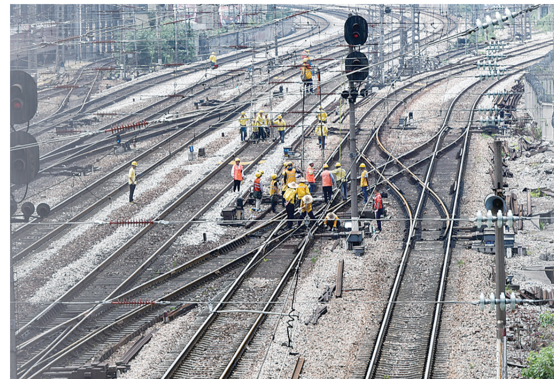
▲6月18日,京广线株洲火车站段,工作人员顶着烈日施工 记者 刘震 摄
