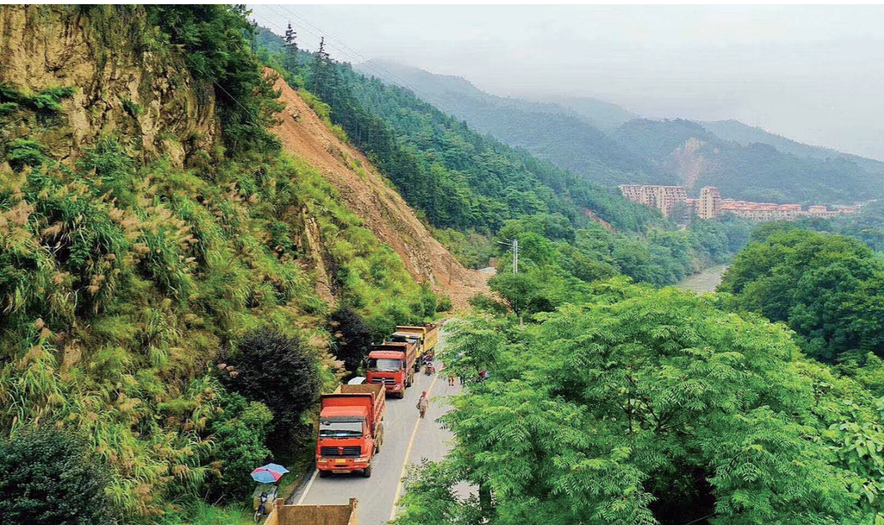
山体滑坡,道路交通中断。炎陵交警供图
