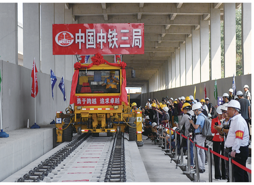
6月12日,铺轨机在京张高铁清华园隧道进行铺轨作业。新华社记者 张震霖 摄
