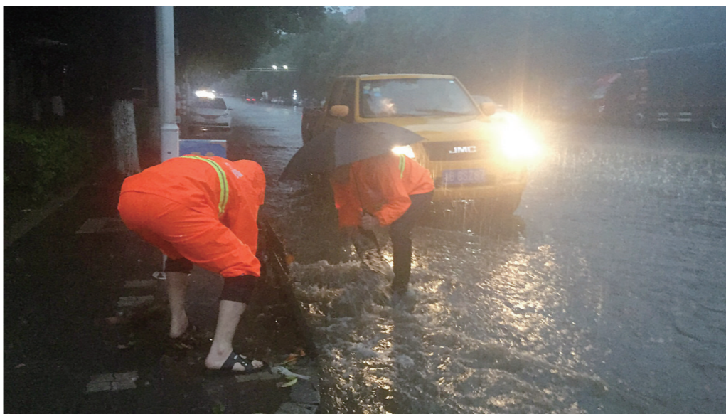
市政工程维护处应急队员们正在现场作业。吴楚 摄
