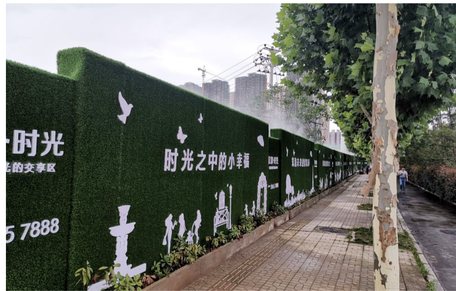
▲工地围挡穿上“绿衣” 记者 伍靖雯 摄
