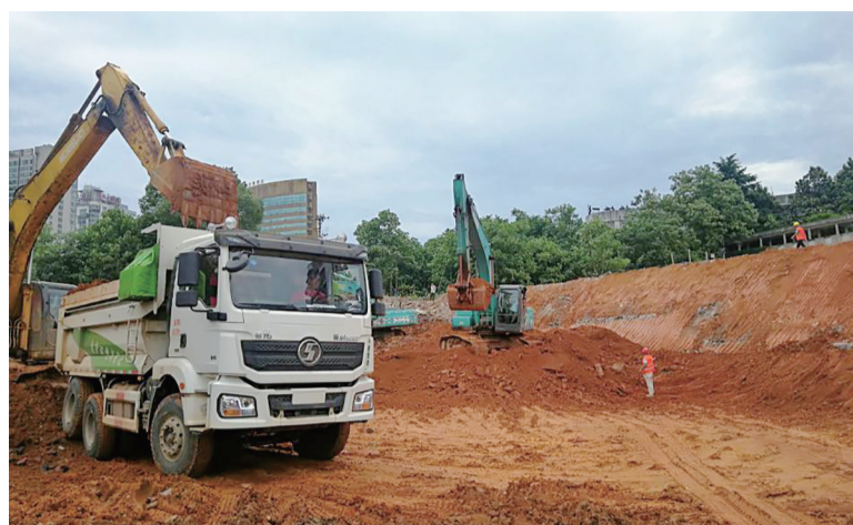
▲施工现场 记者 李卉 摄
