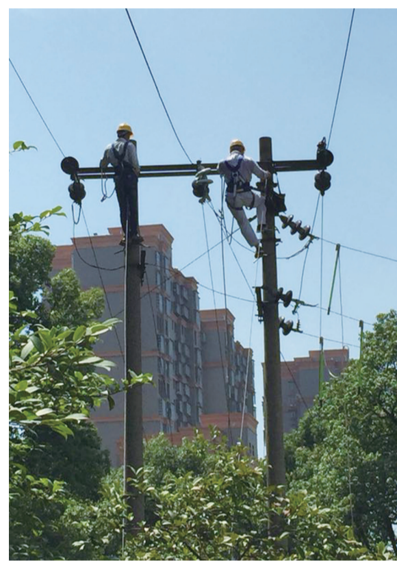
工作人员正在更换线路设施。高晓燕 摄
