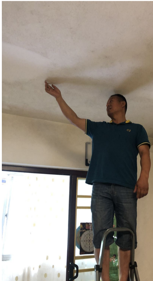
▲大匠风公司专业人员查看天花板长霉情况 记者 郑炜青 摄
