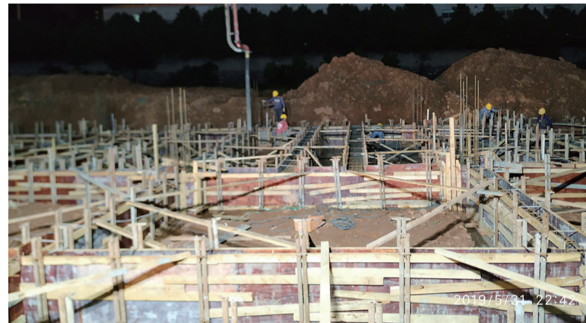
▲5月31日,上海三湘建筑工程有限公司夜间浇筑混凝土 记者 姚时美 摄
