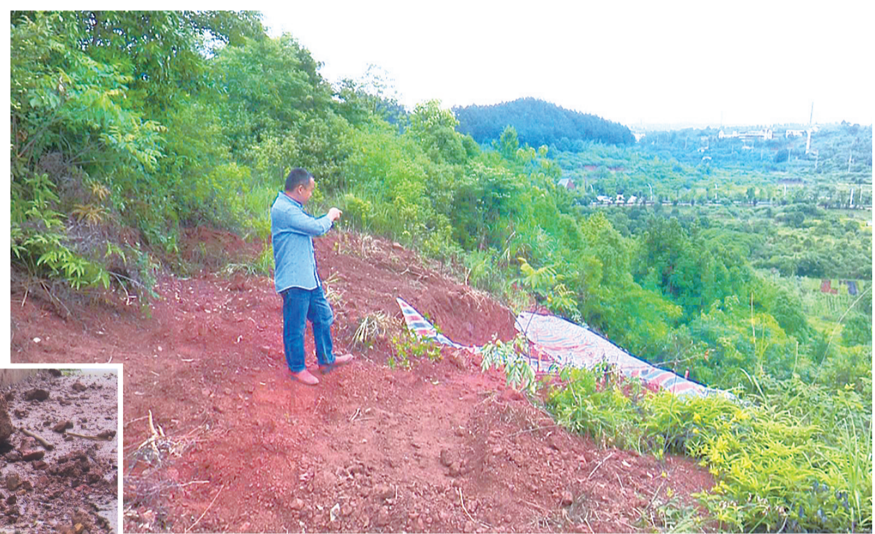
▲徐先生指着被挖的山体,局部已铺上彩条布 ◀房屋后墙外不少泥土未处理 记者 陈驰 摄
