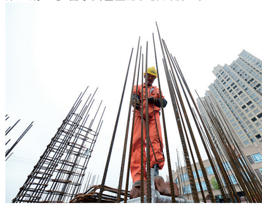
农民正在建筑工地施工 谭浩瀚 摄
