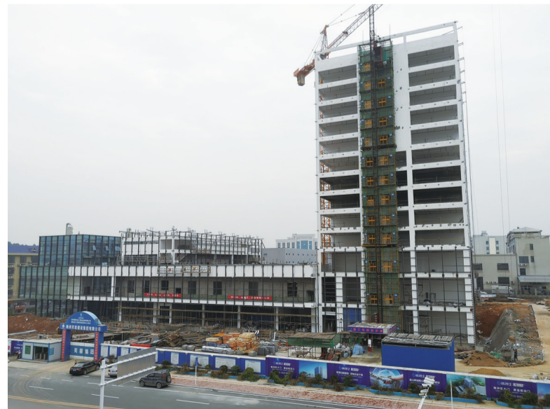
▲采用的装配式建筑国投金汇中心 受访者供图
