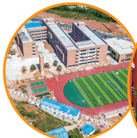
▲城区一所正在建设的学校
