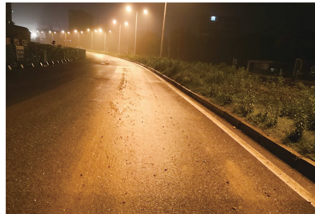
▲砂石漏撒造成路面“斑斑点点” 通讯员供图
