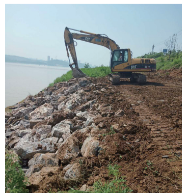
抛石除险施工现场。株洲日报社 成建梅 供图
