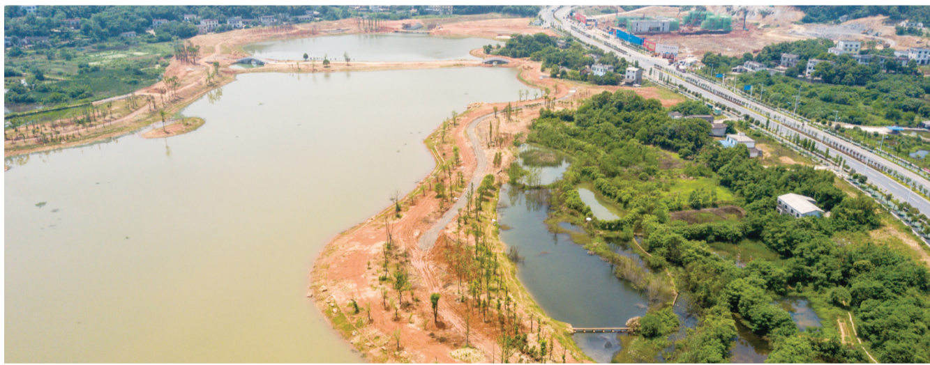
5月17日，从空中俯瞰明照湖，其附属的道路、桥梁和绿化工程已见雏形，未来有望成为休闲生态湿地公园。明照湖位于荷塘区金山新城核心区，紧靠沪昆高速株洲东出口，是规划中的大型城市水利配套建设项目，总用地面积817.72亩。株洲日报记者 刘震摄
