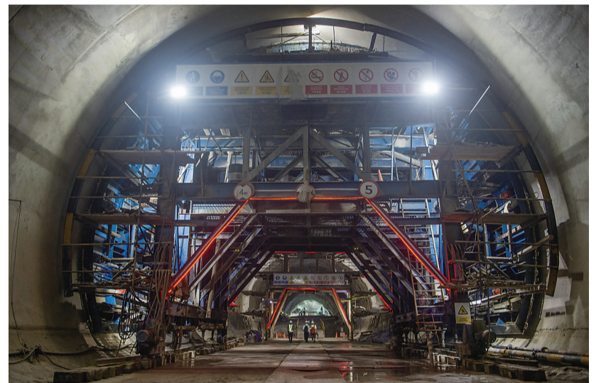
由中国中铁三局集团有限公司承建的印度尼西亚雅加达—万隆高铁项目瓦利尼隧道5月14日贯通,标志着雅万高铁建设取得阶段性重要进展,为全线加快建设奠定了坚实基础。
