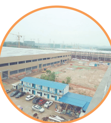
神通光电新基地建设现场。刘芳摄
