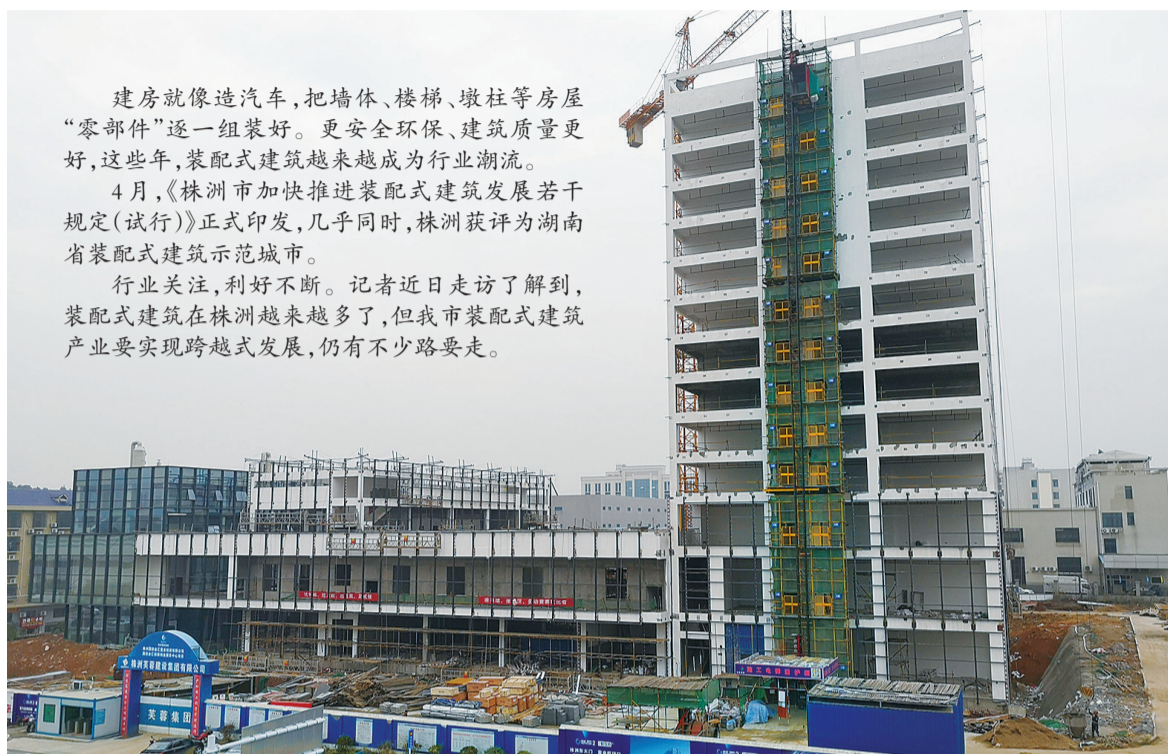
▲即将建成的国投金汇创新创业服务中心项目,图中在建的建筑就是装配式建筑 受访者供图
