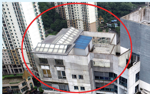
小区楼顶违法建筑(红圈内)。株洲日报记者 谭浩瀚 摄
