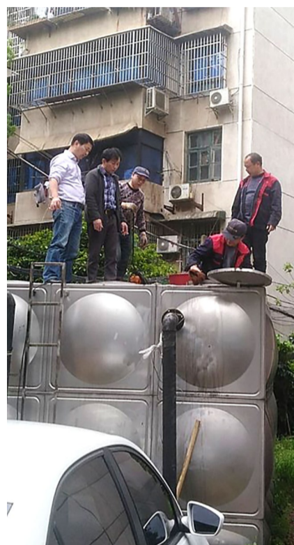
▲清理小区二次供水水箱 通讯员供图
