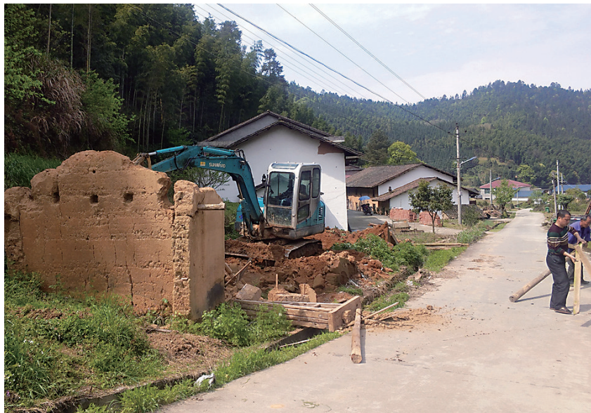
图为旧宅拆除施工现场。潘成文/摄
