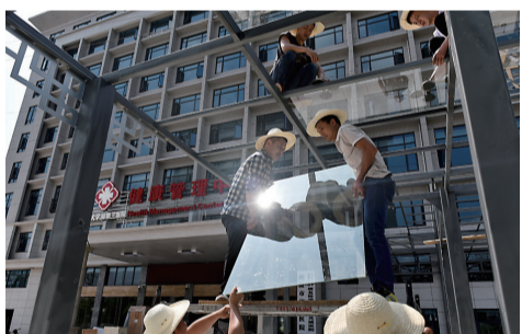
正在建设的醴陵市福田医养中心。 株洲日报记者 刘震摄
