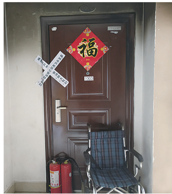
▲起火住户的大门已被贴上封条,门和周边墙壁被熏黑 记者 姚时美 摄
