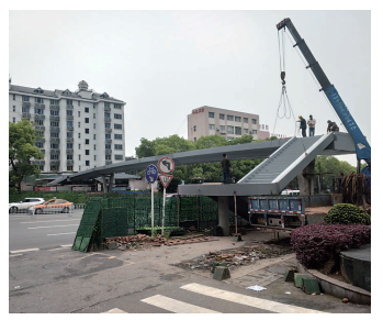
人行天桥施工现场。(刘平摄)
