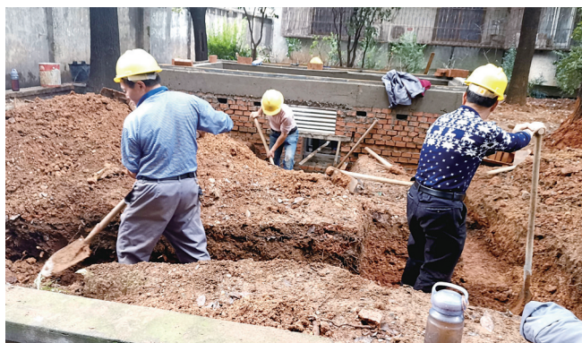
汇达花园1栋西北侧原电力施工现场。沈全华 摄
