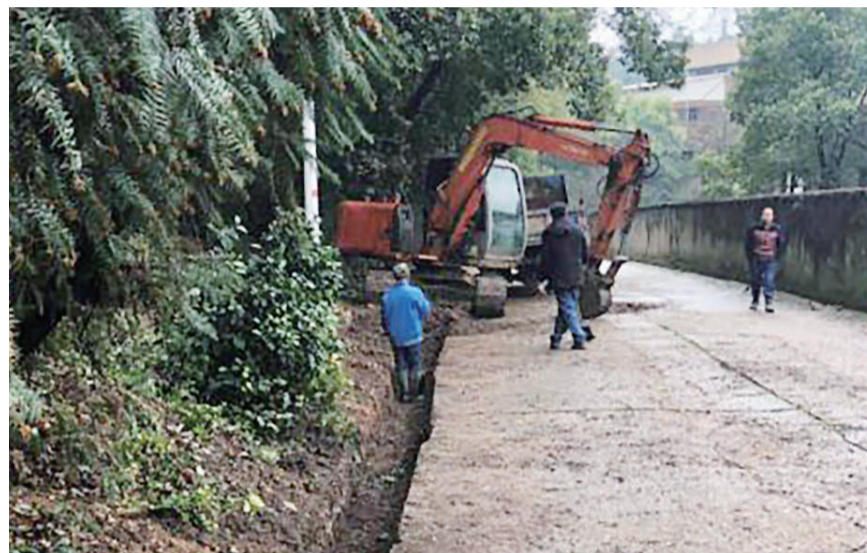
▲排水渠清理施工现场 记者 李卉 摄
