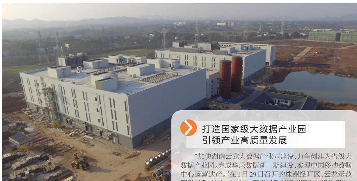
▲中国移动(湖南株洲)数据中心一期工程。 潘帅摄
