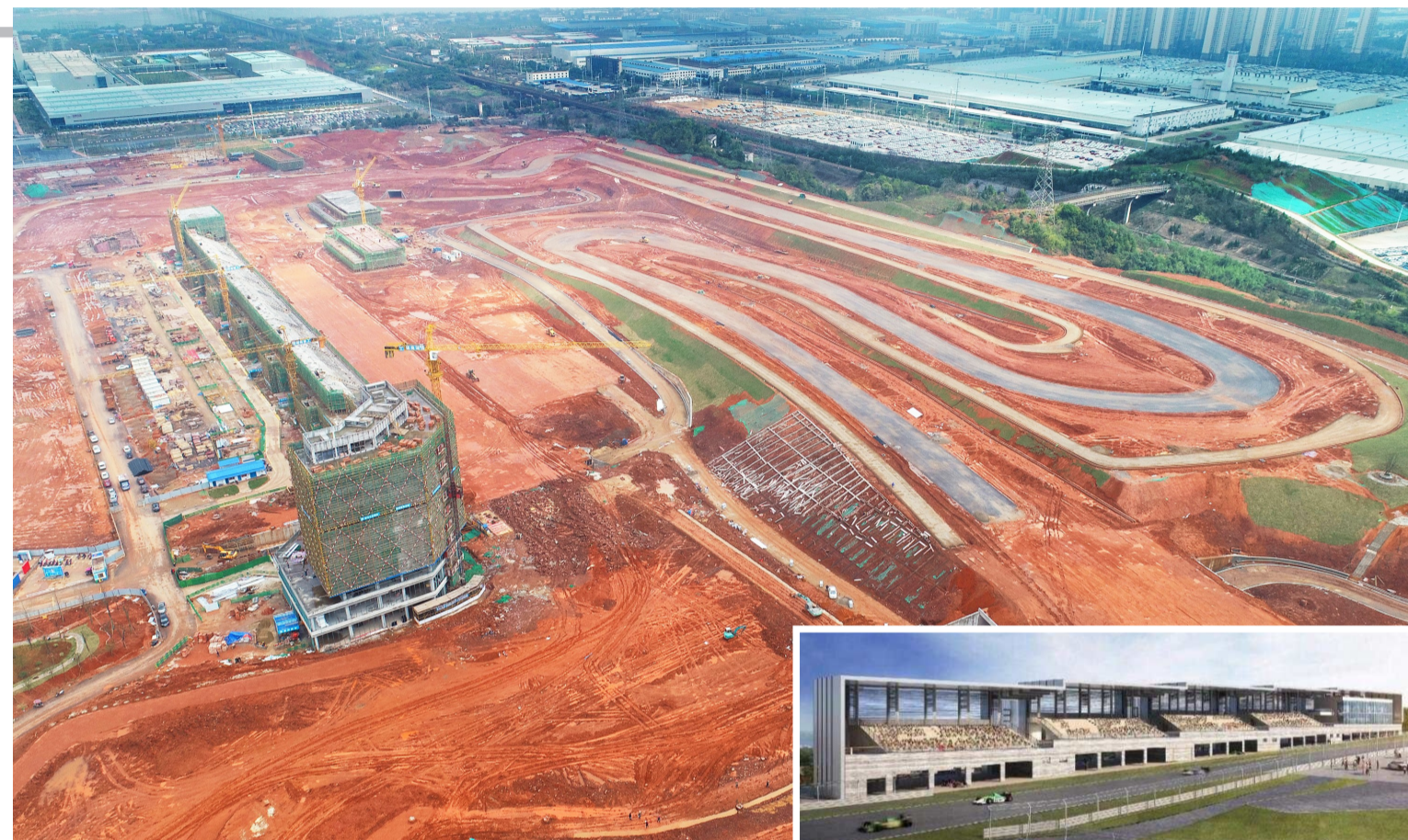
▲航拍正在加紧建设的株洲国际赛车场 记者 谭浩瀚 摄
