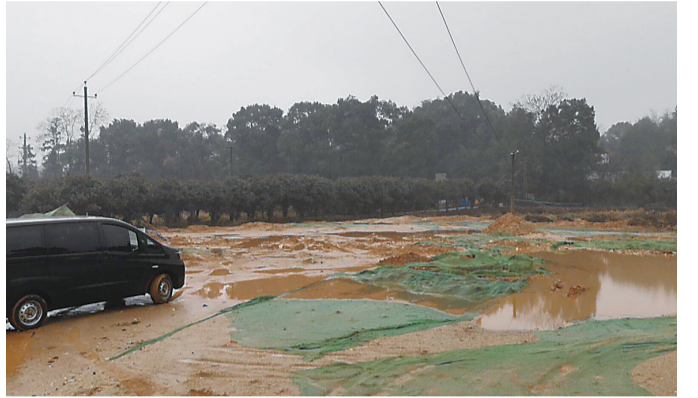
▲黄泥水流到路面 通讯员供图
