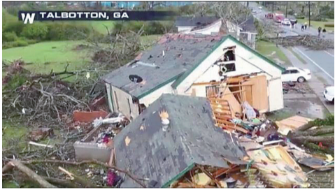
▲风暴过后,房子严重受损
