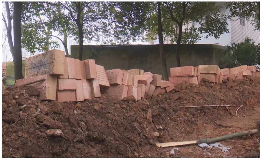
▲幼儿园圈占绿化区域,施工已被叫停 记者 陈驰 摄
