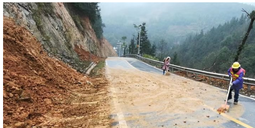
▲工作人员清理塌方现场 通讯员供图
