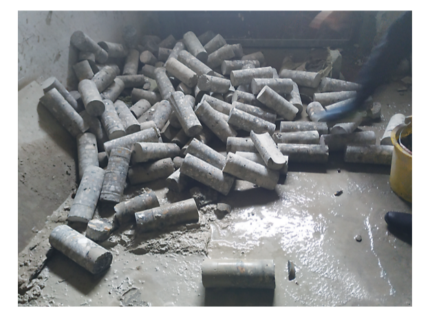
墙上钻洞取出的材料 记者 姚时美 摄
