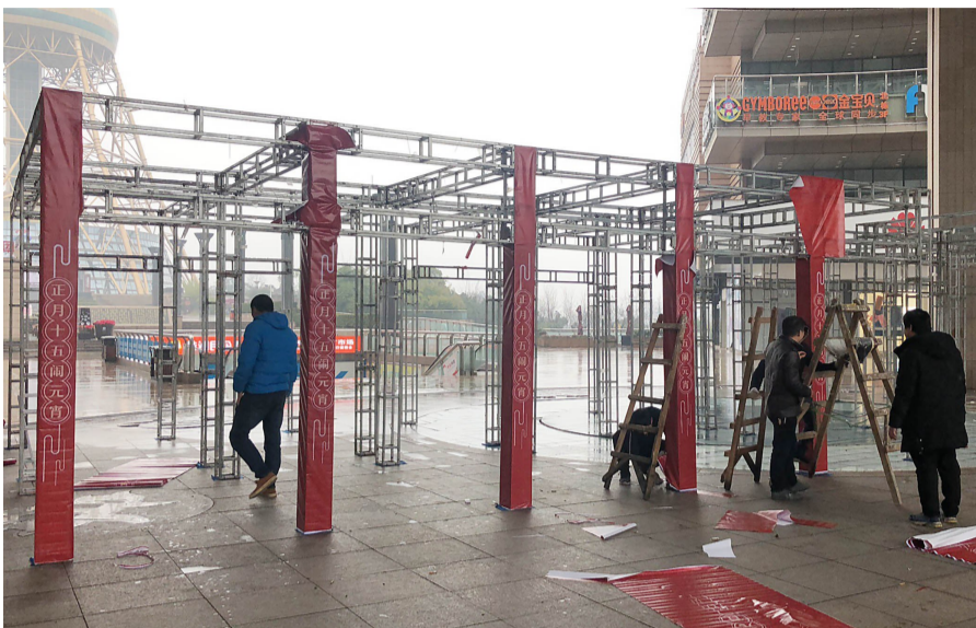
▲神农城日丰庭游园会场,工作人员正在搭建雨棚 记者 肖蓉 摄
