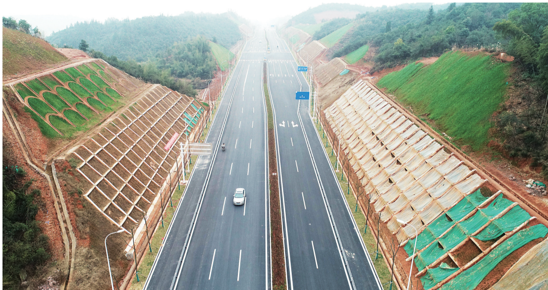
▲航拍正式通车的龙洲路 记者 谭浩瀚 摄
