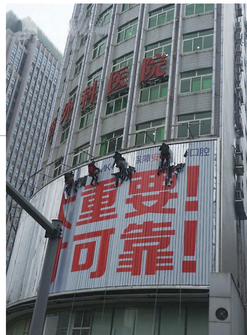
▲涉事整形医院拆除户外广告牌,院内正常营业
