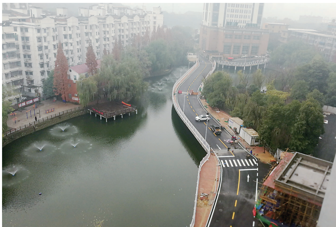
▲新建成的曹塘坝路 记者 戴凇 摄
