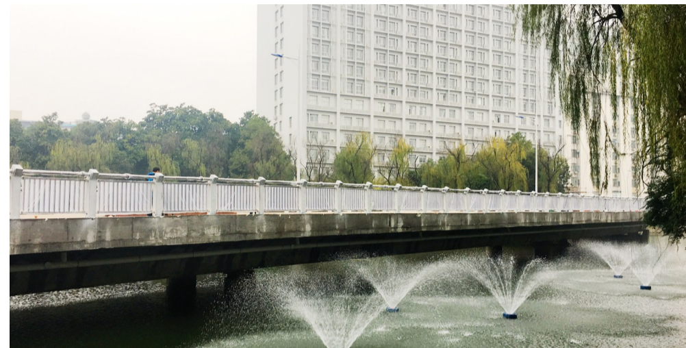
▲新建成的曹塘坝路 记者 戴凇 摄
