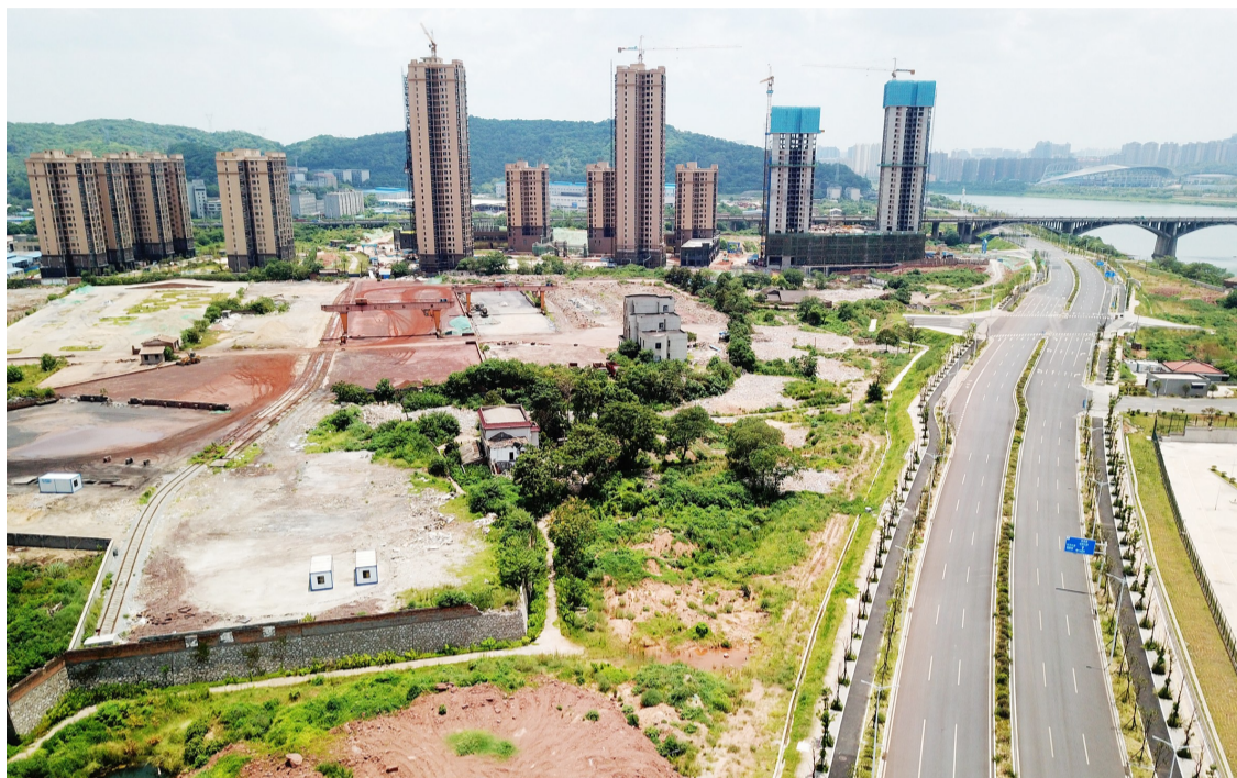
▲清水塘部分关闭或搬迁的企业已拆除,新建起了高大的楼房和宽敞的道路 记者 戴凇 摄
