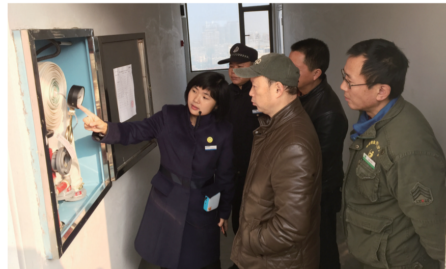
业主代表检查消防栓运行情况 记者 周嵩 摄
