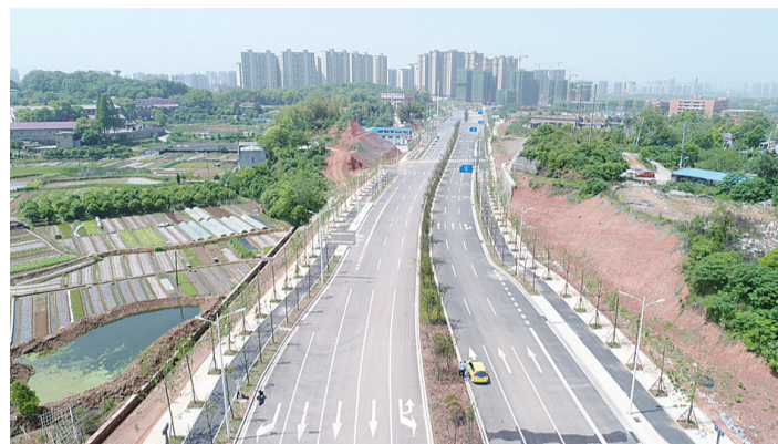
▲新塘路三期全景 通讯员供图
