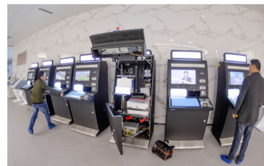
▲工作人员正在进行设备调试 记者 刘震 摄
