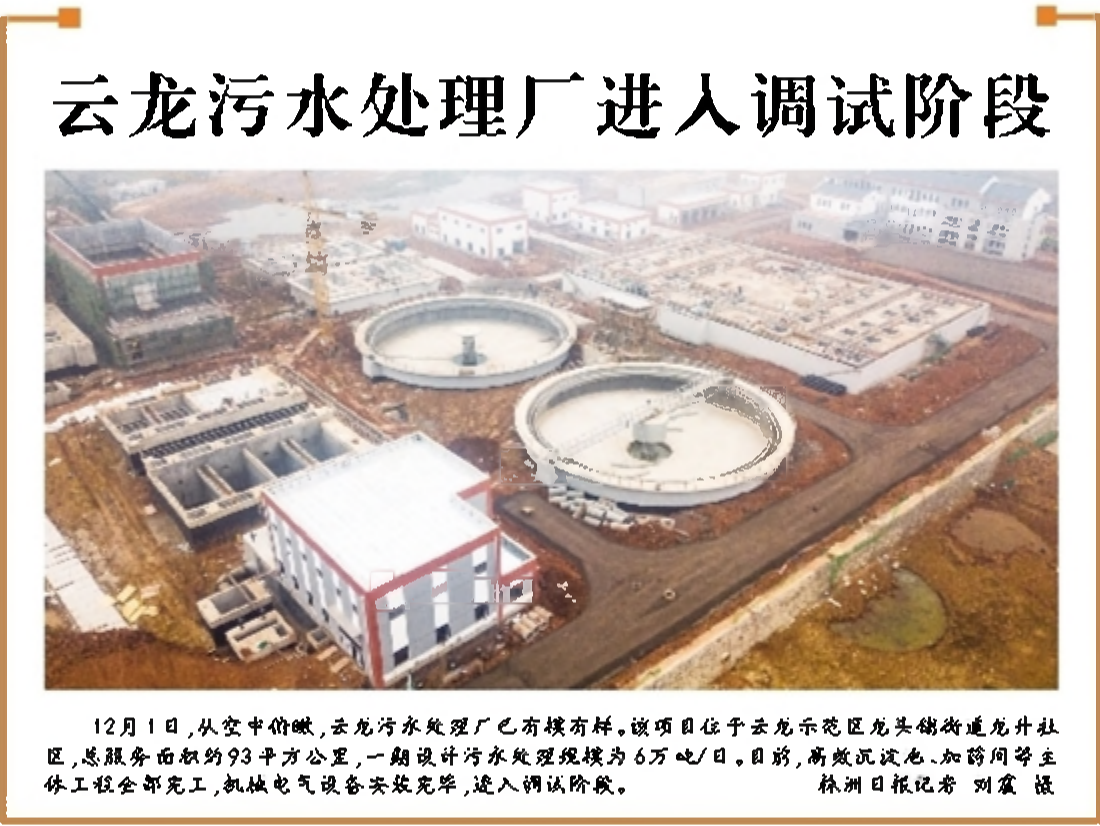
12月1日,从空中俯瞰,云龙污水处理厂已初具规模。该项目位于云龙示范区龙头铺街道龙升社区,总服务面积约93平方公里,一期设计污水处理规模为6万吨/日。目前,高效沉淀池、加药间等主体工程全部完工,机抽电气设备安装完毕,进入调试阶段。
