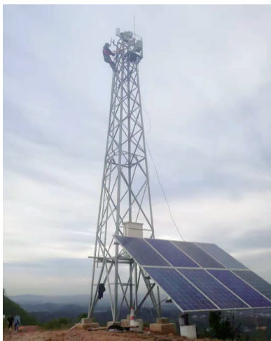
▲施工人员爬上瞭望铁塔安装云台监控设备 通讯员供图
