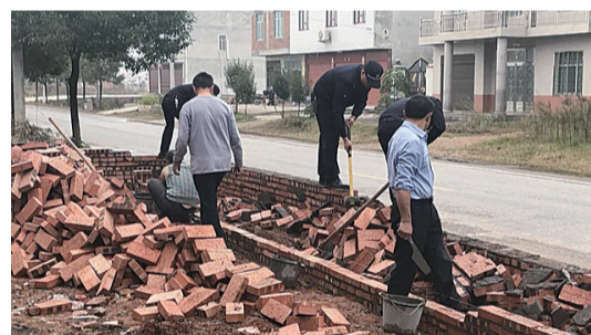
▲工作人员在拆除违建围墙
