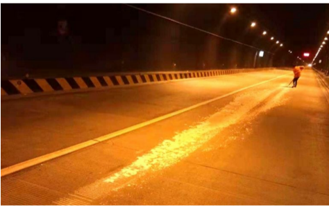
▲路政人员正在清理散落的石灰粉 通讯员供图
