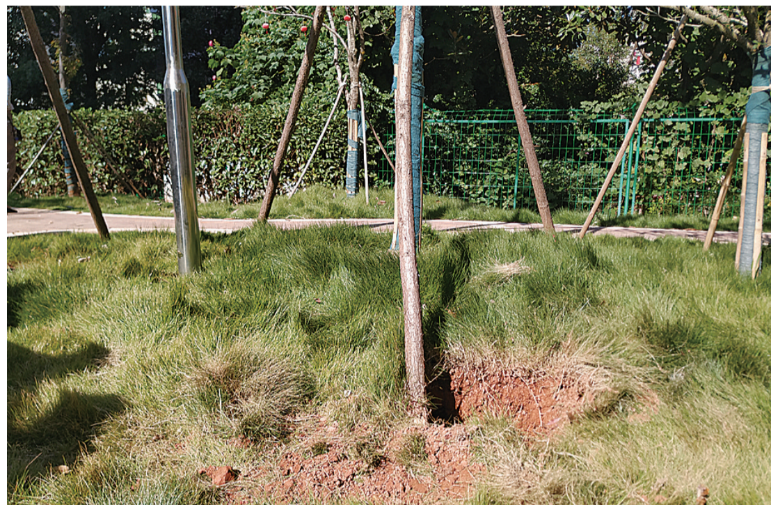
草地上挖了围墙基坑,部分绿化和道路将位于围墙外 记者 姚时美 摄
