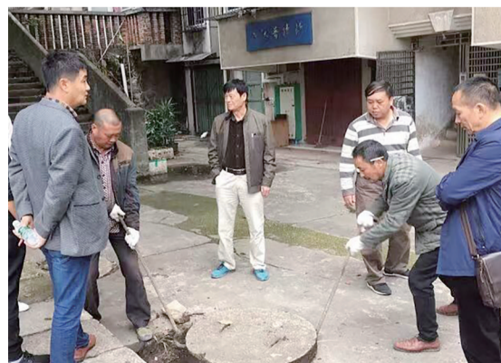
▲株洲车辆厂生活区内,施工人员正在对下水管网进行改造 通讯员供图
